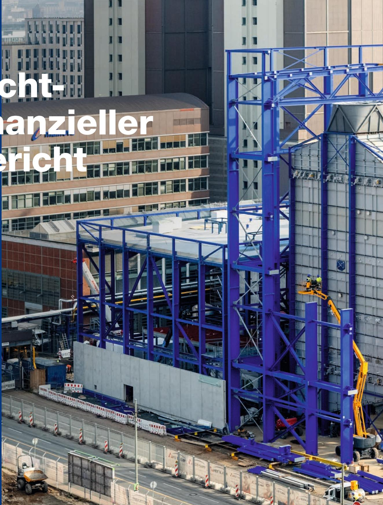
**Es geht voran mit dem vorzeitigen Kohleausstieg:** Das Heizkraftwerk West wird vom Kohle- zum wasserstofffähigen Gaskraftwerk. Wichtige Meilensteine sind erreicht: Die beiden H<sub>2</sub>-ready Gasturbinen sind installiert, die beiden rund 35 Meter hohen Abhitzedampferzeuger (rechts im Bild) stehen und auch an der künftigen zentralen Wärmewarte wird schon gebaut.
